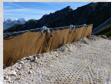
Stato di fatto in corso d'opera
