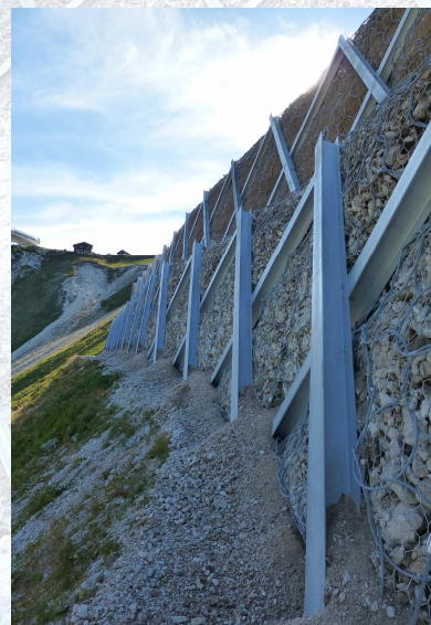
Stato di fatto a lavori ultimati
