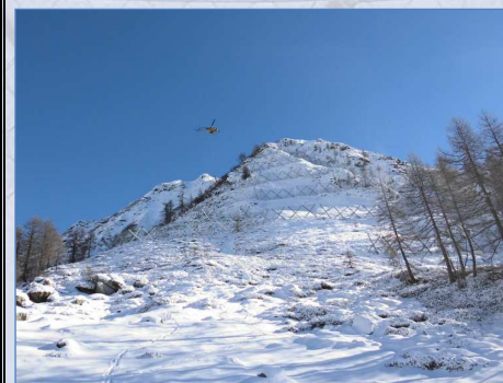
Vista d'insieme dell'intervento dopo la nevicata
