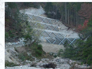
Stato di fatto a lavori ultimati
