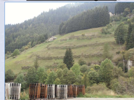
Vista d'insieme dell'intervento - zona n°1
