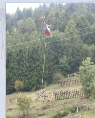
Fase d'installazione "VELA-Fermaneve" - zona n°2
